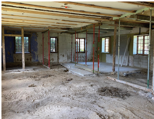
Konfirmandstuen under ombygning
